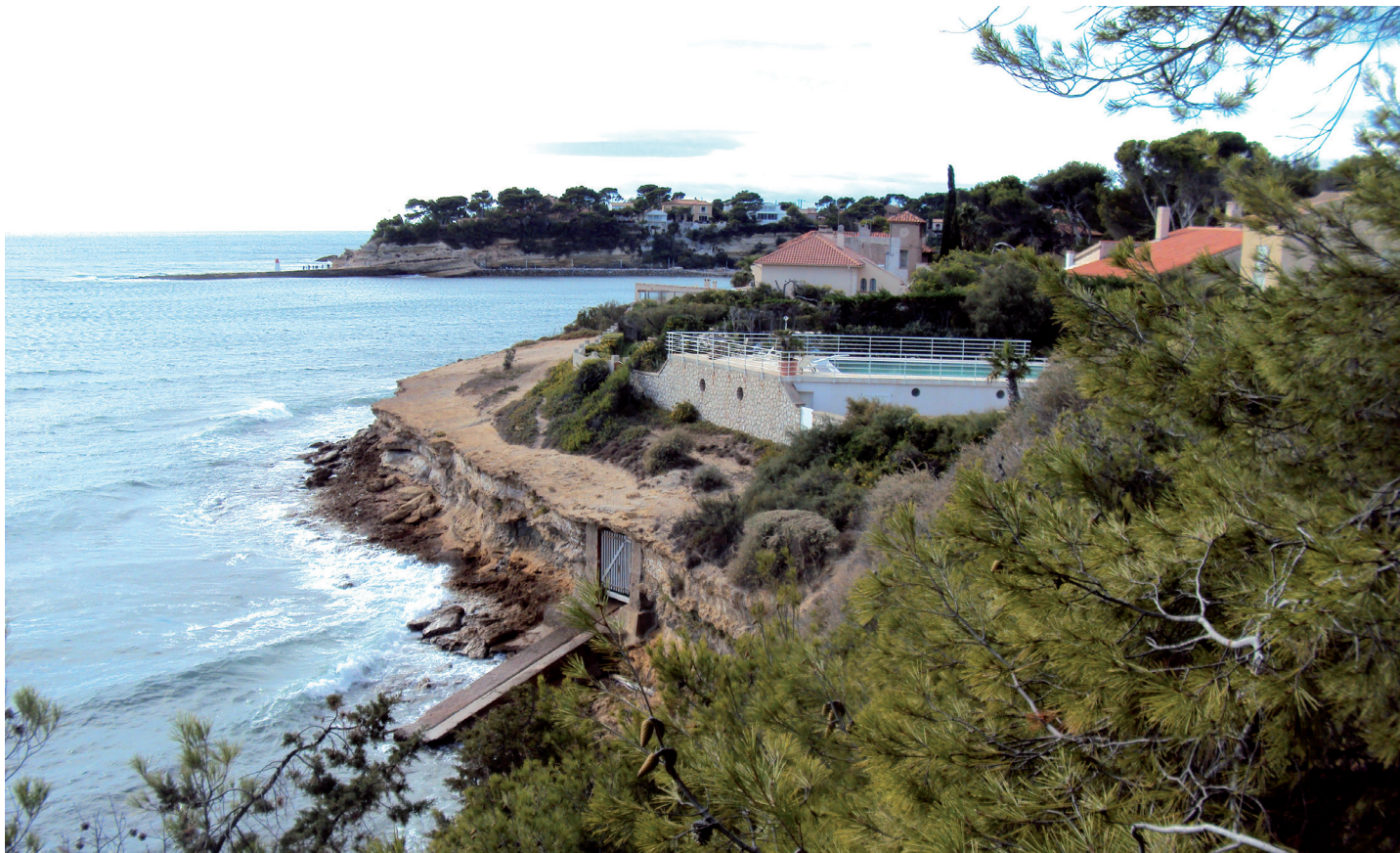
Photo 4. Exemple d'urbanisation de type villa individuelle avec piscine sur les falaises côtières du littoral de la Côte Bleue (©Cécila Claeys)
