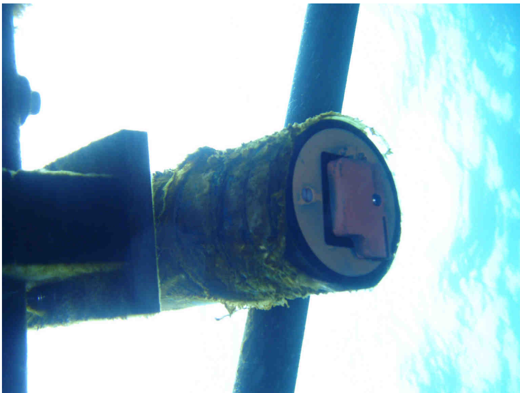
- 4m (photo) : AVANT NETTOYAGE
