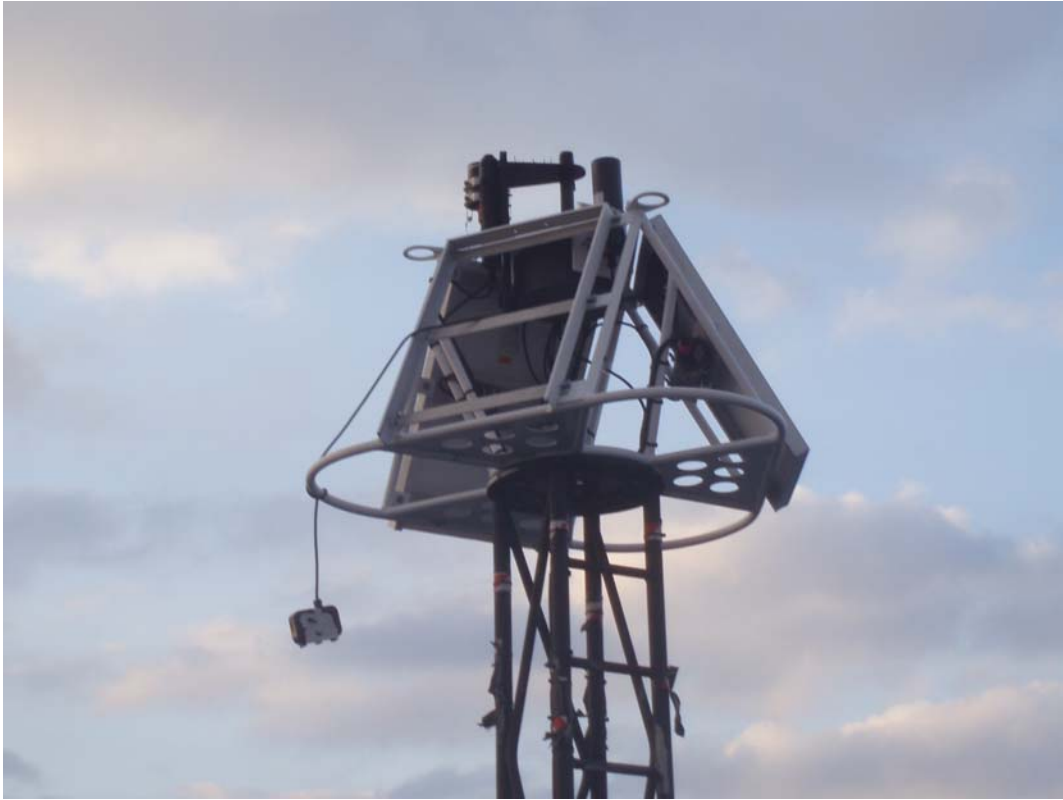
PANNEAUX SOLAIRES (1manquant)
