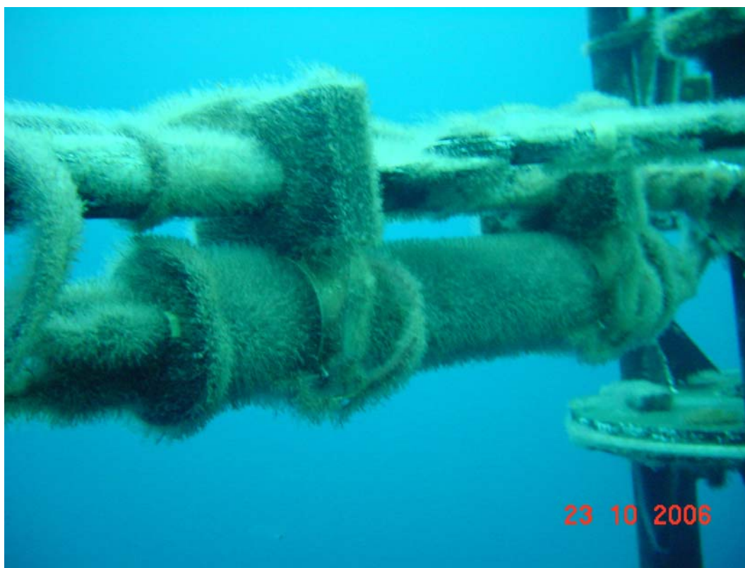
- 9m (photo ) : module – AVANT NETTOYAGE
